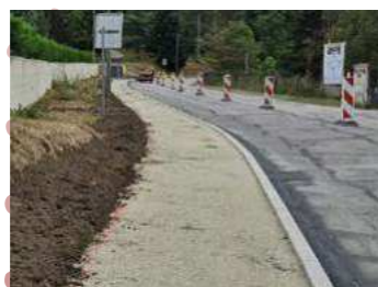
Trottoirs rue d'Auvergne et bientôt réfection d'une partie de la D6
