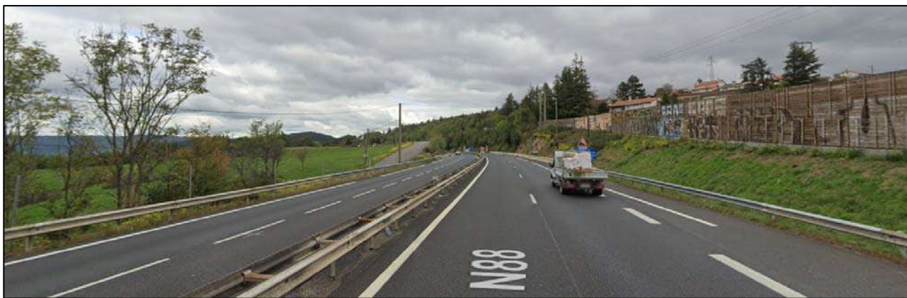
Vue sur la zone AUi1 (secteur Nord) depuis la RN88 dans le sens Le-Puy-en-Velay / Saint-Etienne
