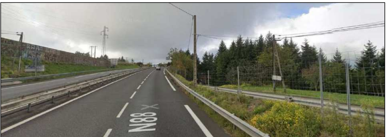
Vues sur la zone AUi1 (secteur Nord) depuis la RN88 dans le sens Saint-Etienne / Le-Puy-en-Velay
